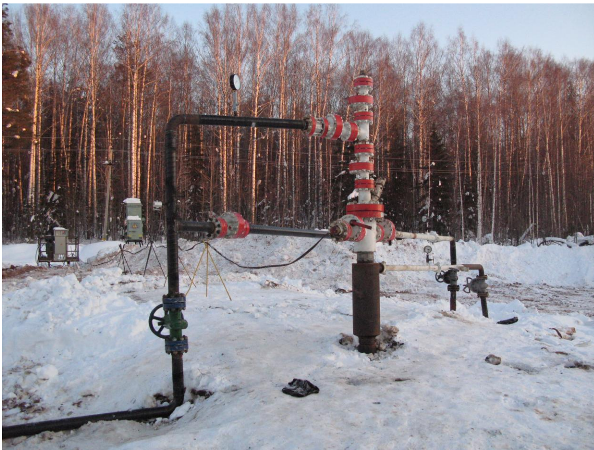
Рис. 3. Скважина для предварительного сброса воды в НГДУ «Воткинск» ОАО «Удмуртнефть»
