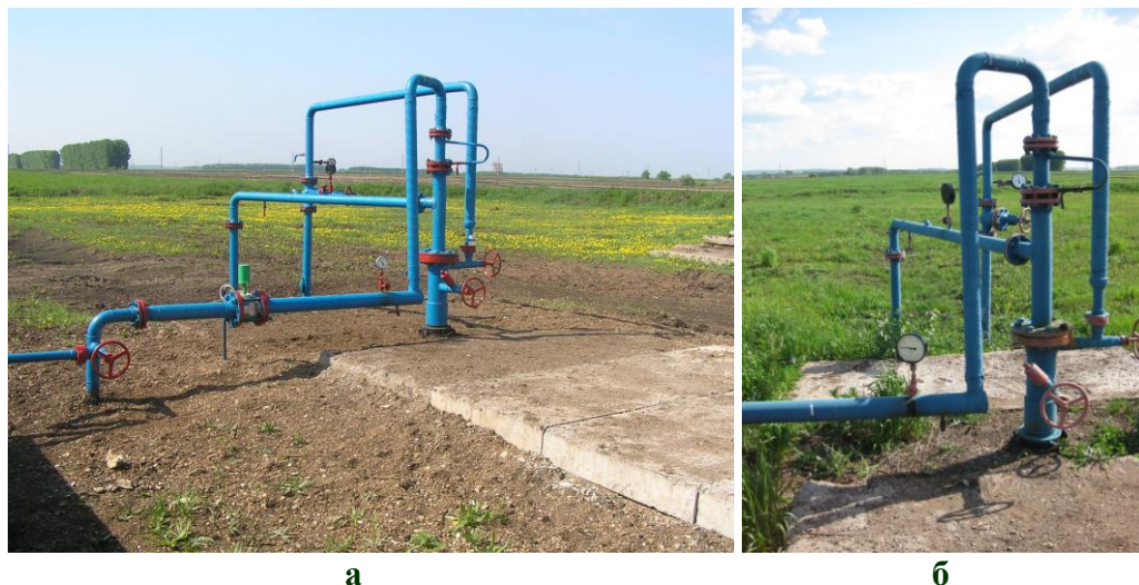
Рис. 1. Первая построенная скважина для предварительного сброса воды (а – май 2005 г.; б – май 2009 г.)
